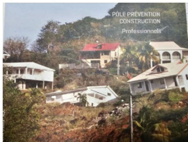
Figure 24 : Photographie du lotissement de «Soleil Levant» Source : Article de pôle prévention témoignant du glissement à «Soleil Levant»,
