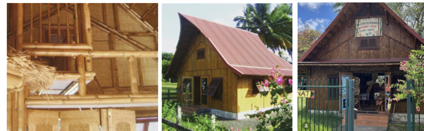
Figure 30 : Photographies d'une maison construite à Anse Figuière, Martinique en 2008 Source : Guadua Polmone construction
