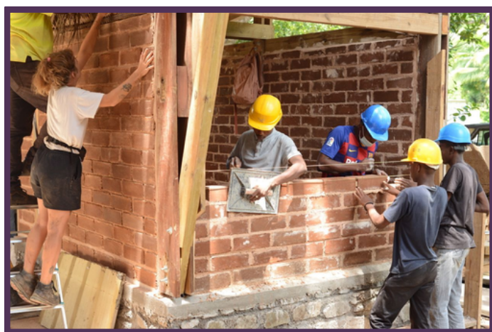
Photo : © Encore Heureux et Co-Architectes Construction du Faré du lycée des métiers du bâtiment à Longoni (Mayotte) : socle en pierre, structure en bois, murs en blocs de terre comprimée.
