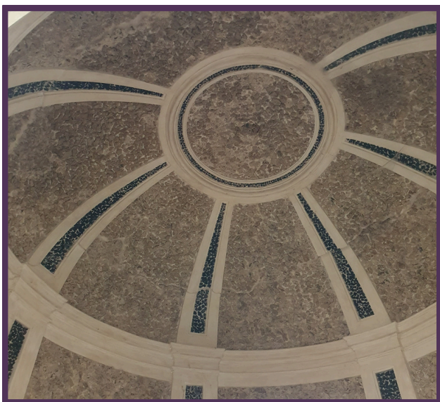
Coupole reconstruite suite au séisme de l'Aquila en conservant la fissure provoquée par le séisme
