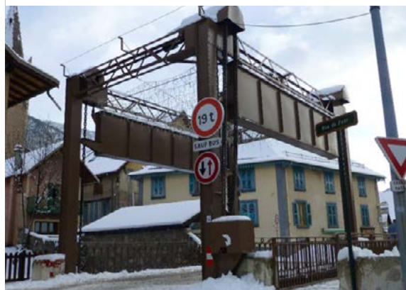
Visite du Pont Levis, entretien de la mémoire sur les habitudes anciennes concernant le risque torrentiel.
